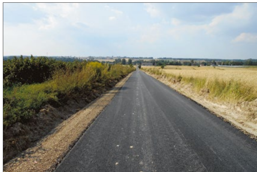
Nowa nawierzchnia na drodze w Ostrowie
