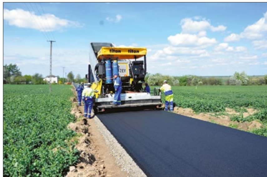
Asfaltowanie drogi w Wilkołazie Górnym
